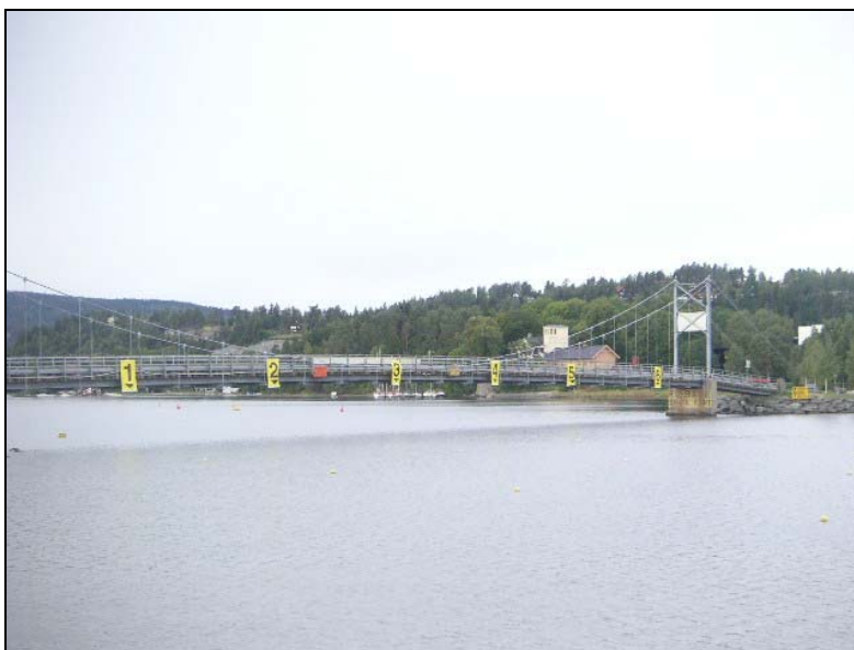
Banemarkørene er laget i PVC-duk og henges opp på brua så midt i banen som mulig. På motsatt side av brua henges det opp stort skilt med «stengt pga ro- og padleregatta»!
